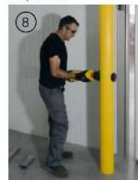
Colocación brazo a mástil Fixing arm to post
