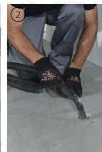
Aspiración y limpieza Aspiration and cleaning
