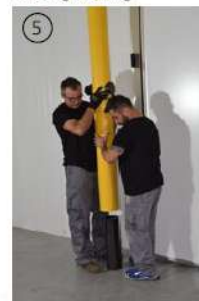
Introducir jamba Post placement
