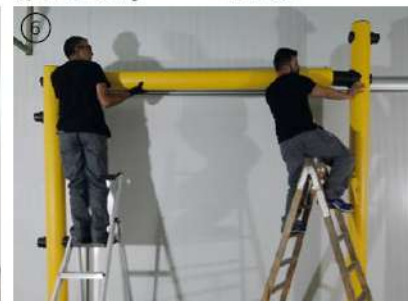
Introducir dintel Crossbar placement
